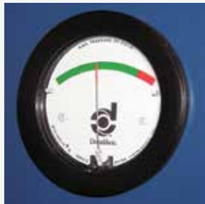
Indicador de presión diferencial identifica mantenimiento del filtro.
